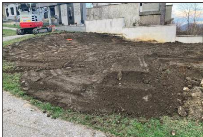
Aus der Baustelle wurde ein neuer "Ort des Lebens" - Fertige Baumbestattungsanlage am Pfarrfriedhof siehe Titelbild.
